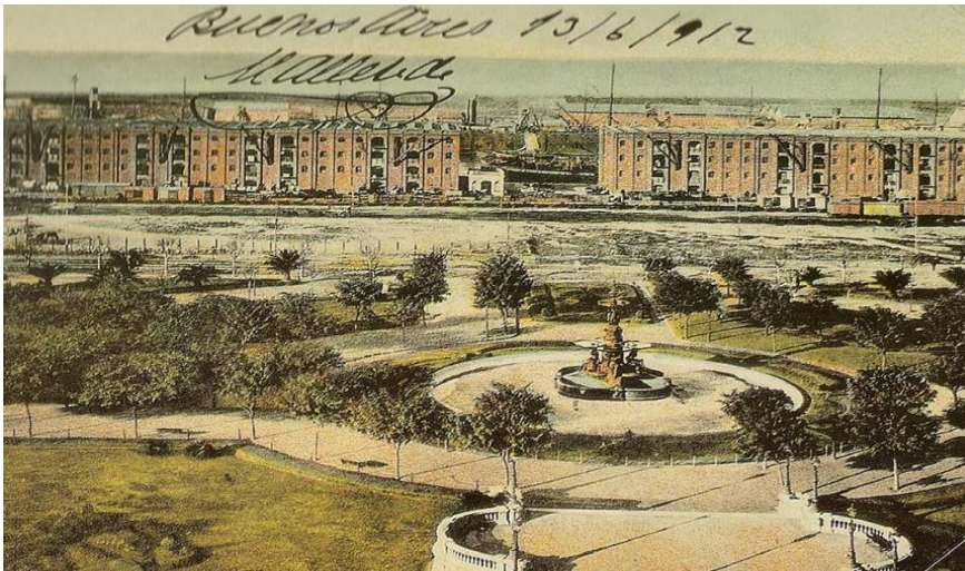
Ubicación original Paseo de Julio 1912
